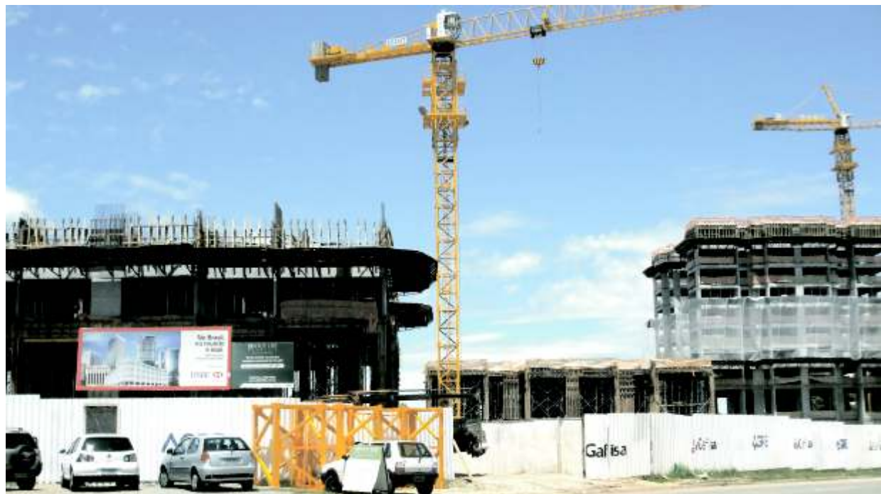
Vítima tinha apenas 25 anos e trabalhava em construção de condomínio de luxo
